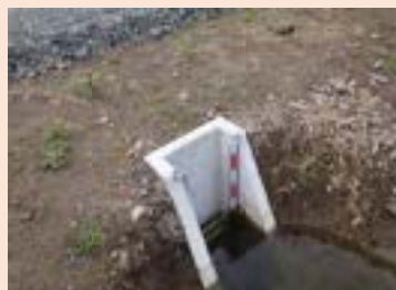
コンクリートマス
