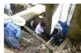
応急措置による土砂撤去
