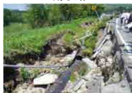
【管路の破損】阿蘇郡西原村
