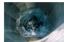
熊本市内の水道水を供給する 健軍水源地の自噴井戸
