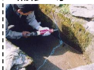
水路のひび割れ補修
