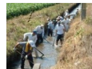
水路の泥上げ
