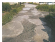
農道の窪みの補修
