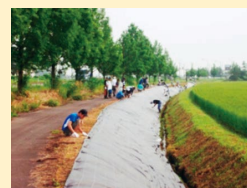
共同購入による防草シートの設置
