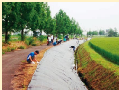
共同購入による除草シートの設置
