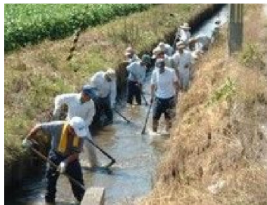
水路の土砂さらい
