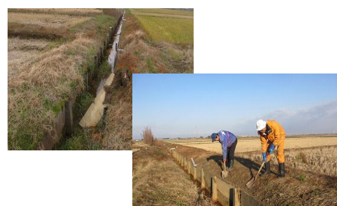
水路の軽微な補修等
