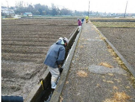
泥上げの様子
