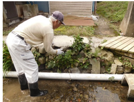
施設の補修・更新
