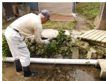
施設の補修・更新
