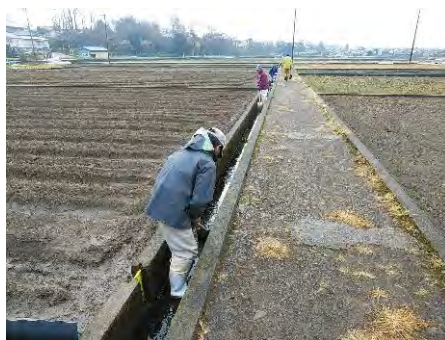
泥上げの様子
