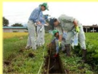
水路の点検診断
