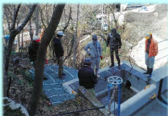
構成員による水路の点検
