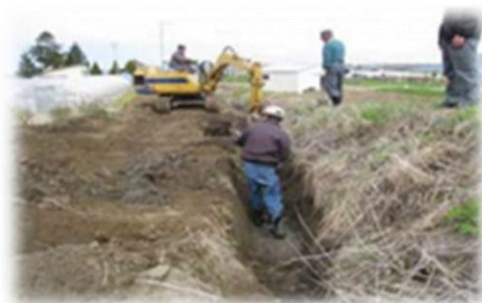
農道側溝の土砂上げ
