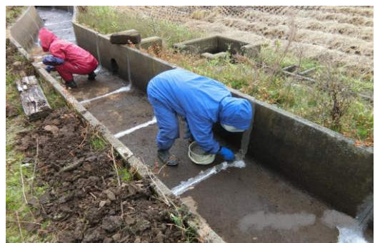
水路の目地詰め
