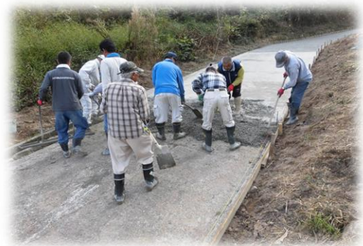
農道をコンクリート舗装で再生
