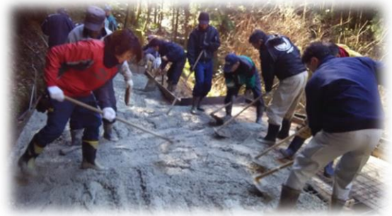
直営施工による農道の舗装
