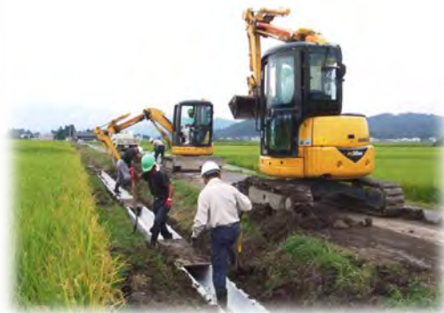
直営施工による水路敷設
