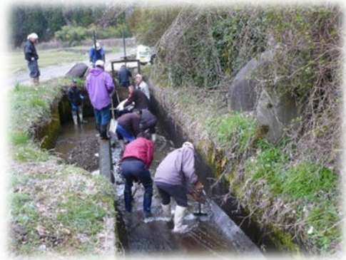
水路の泥上げ
