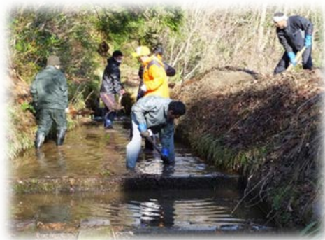
水路の清掃作業の様子
