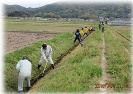
共同作業による水路の泥上げ
