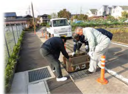
戸蓋（堰板）の設置
