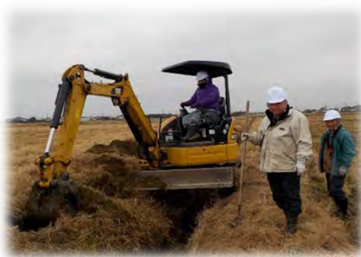
構成員による水路浚渫
