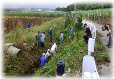
水路の泥上げ
