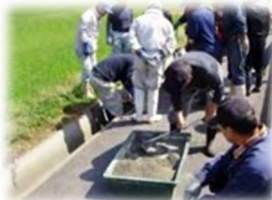
目地詰め作業
