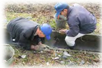
水路の目地詰め
