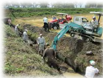
バックホウを利用した泥上げ
