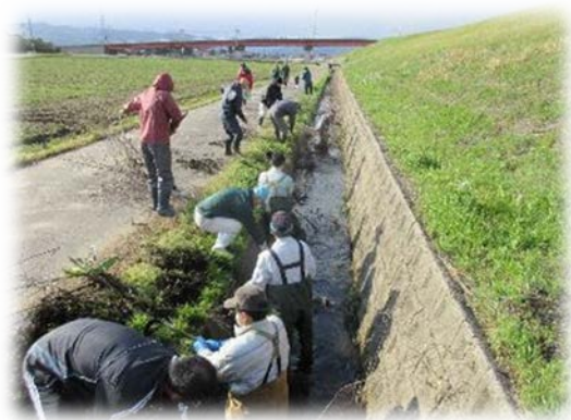
泥上げの様子
