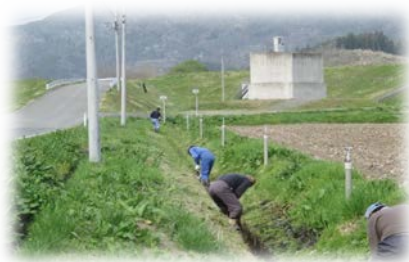
水路の泥上げ作業
