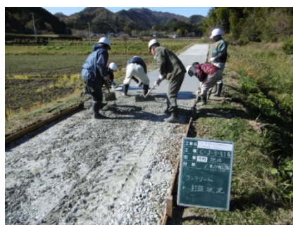
農道のコンクリート打設
