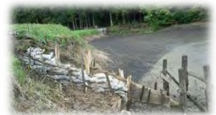
土のう積みによるため池の補修
