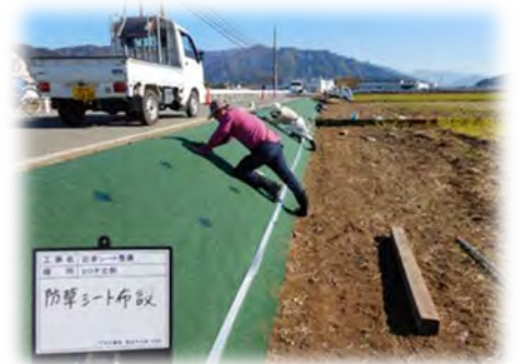
法面への防草シート張り
