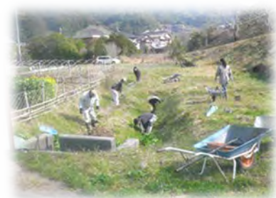
水路の泥上げ
