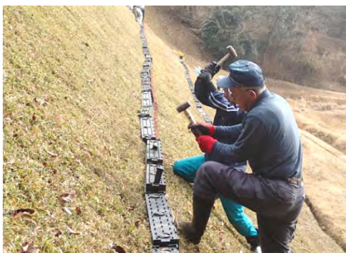
ため池法面の足場設置
