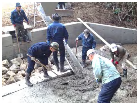
直営施工によるため池の補修
