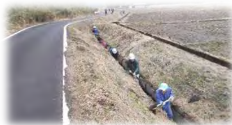
水路の泥上げ
