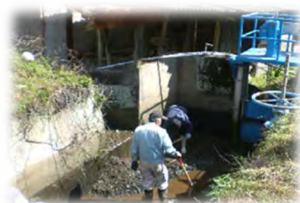
ため池ゲートの土砂上げ作業
