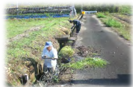
農業用水路の土砂上げ作業
