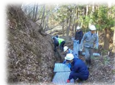
水路の蓋設置
