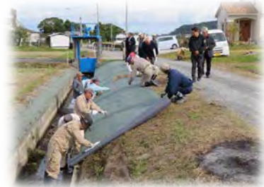
防草シートの敷設
