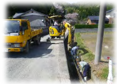
水路の泥上げ
