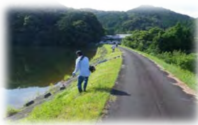
ため池法面の草刈り
