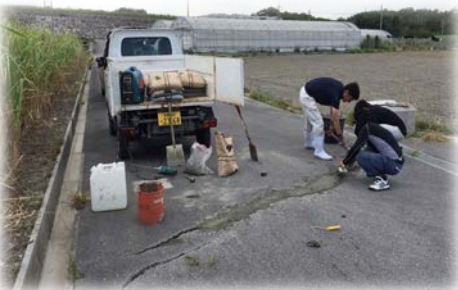
農道の軽微な補修
