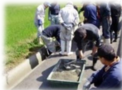
目地詰め作業
