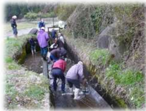
水路の泥上げ
