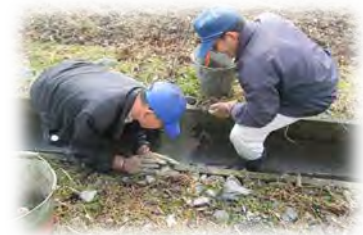
水路の目地詰め
