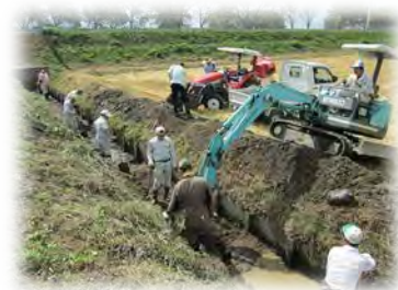
バックホウを利用した泥上げ
