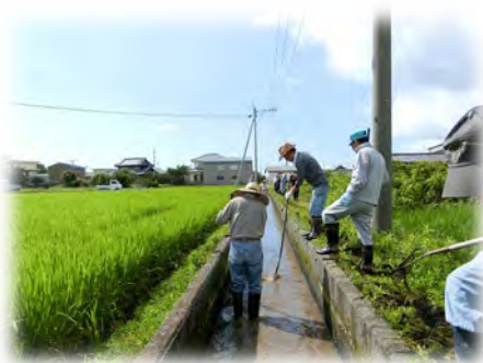
水路の泥上げ
