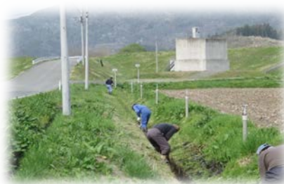
水路の泥上げ作業
