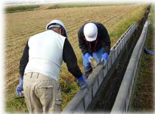
直営施工による水路補修
