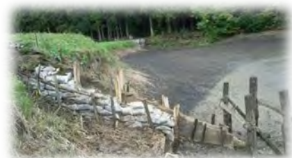
土のう積みによるため池の補修
