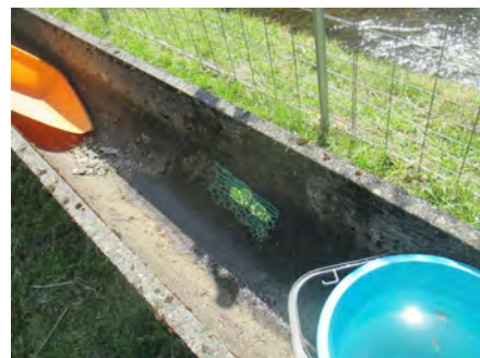
集落の直営で水路補修
