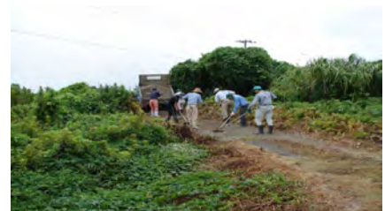
農道整備（再生砂利の敷き均し）
