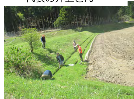
水路泥上げの様子
