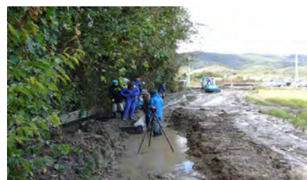
ビオトープ整備（あぜ波設置）
