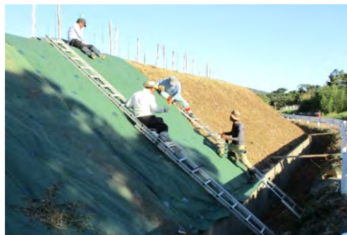
共同活動による防草シート施工
