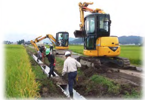
直営施工による水路敷設
