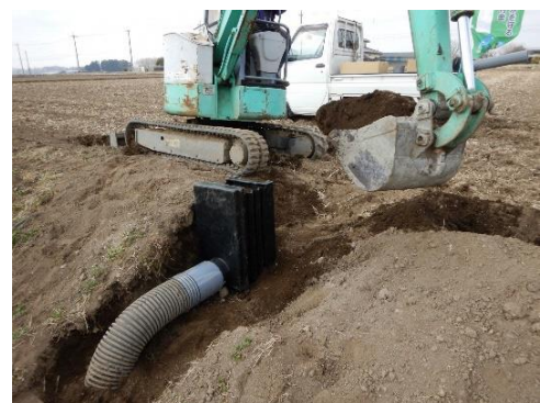
排水枡の設置（田んぼダム）
