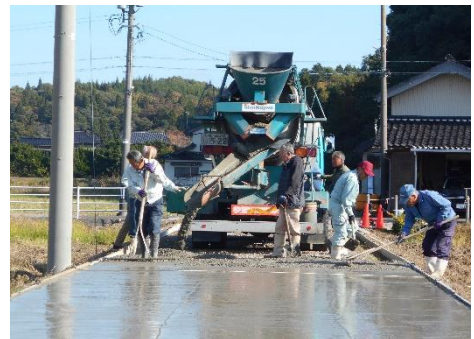
農道のコンクリート舗装
