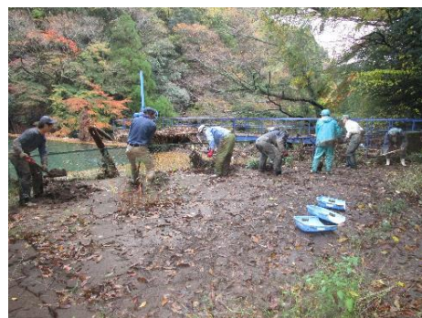
取水口付近の土砂撤去
