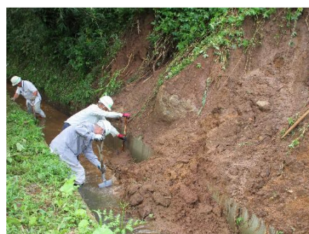
復旧作業の様子 （水路の土砂撤去作業）
