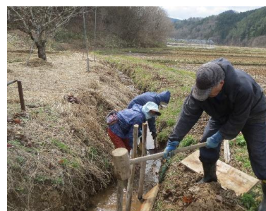
農道の法面補修
