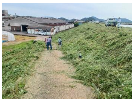
ため池法面の草刈り
