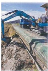
畦畔補修作業
