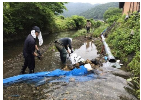
水路清掃・勾配修繕
