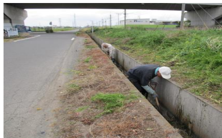
水路の泥上げ
