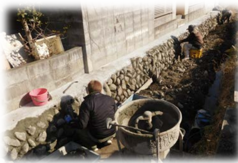
水路の石垣の修繕
