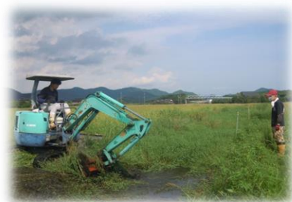
重機で泥上げをする様子
