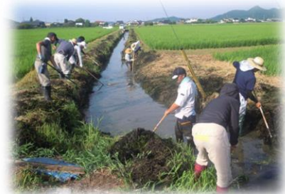
水路の泥上げの様子
