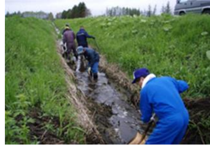
排水路の泥上げの様子
