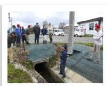
点検・機能診断
