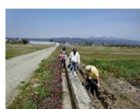
堰払い（泥上げ）
