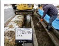
ダブル水路間土砂溝畔のコンクリート張り（月山堂・砂田地区）
