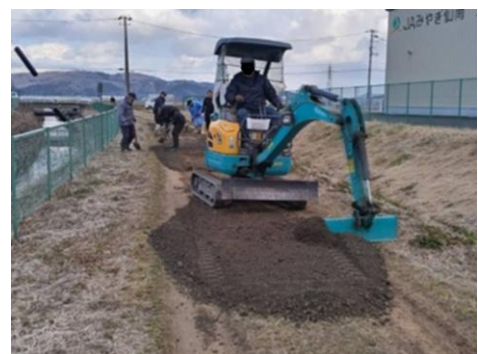
共同作業（農道補修）の様子
