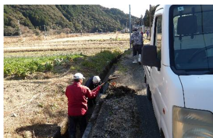
水路の泥上げ作業の様子
