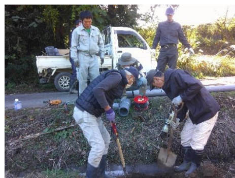
用水路のパイプライン化
