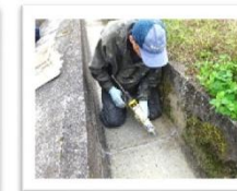
水路目地補修
