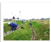
堰払い(泥上げ)
