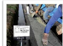
ダブル水路間土砂溝畔のコンクリート張り（月山堂・砂田地区）
