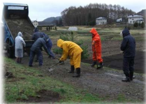
直営施行による農道補修
