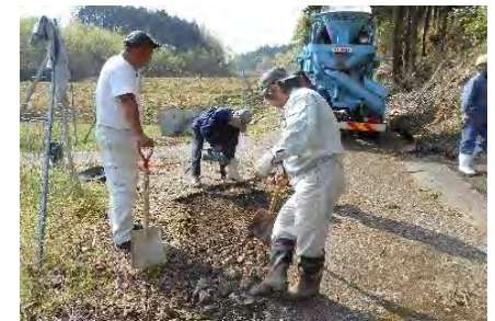
農道補修の様子
