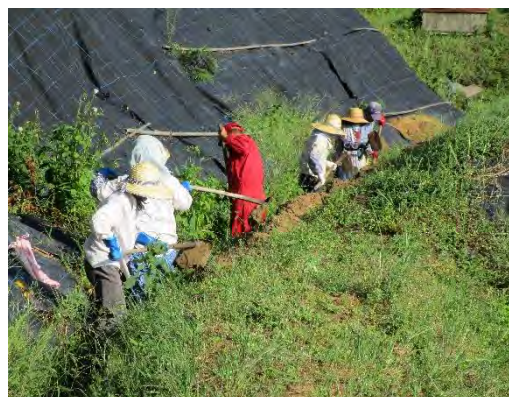
土砂撤去（災害時）
