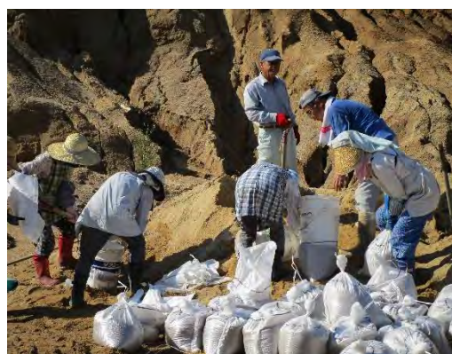
土のう袋詰め（災害時）
