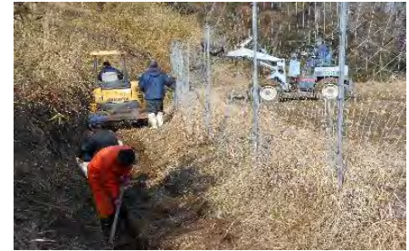
水路の泥上げ作業
