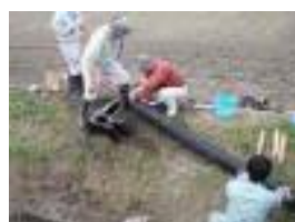
接続・固定状況
